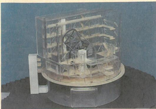
図 12 「すばる」望遠鏡ドーム模型。ドーム上部は橢円柱型で望遠鏡と共に回転する。
